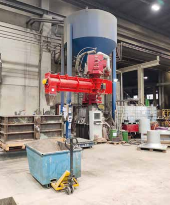
Muottihiekka ei pääse enää loppumaan, kun anturit hälyttävät tukoksista ja täyttöasteesta.
